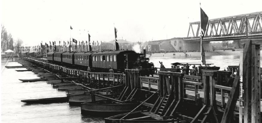
Bis 1938 konnten die Züge von Speyer nach Heidelberg nur über eine Schiffsbrücke über den Rhein fahren. Die neue Brücke wurde 1945 zerstört und im Gegensatz zur Straßenbrücke nicht wiederaufgebaut.
