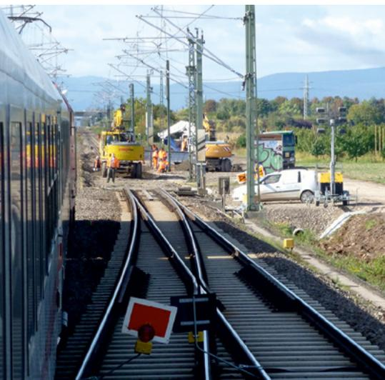
der Vorderpfalz gezeigt: Der 'Grimbart' unterhöhlte die Bahndämme bei Erpolzheim und Eppelsheim so stark, dass der komplette Unterbau instabil wurde. Die Langsamfahrstelle reichte in der Pfalz bald nicht mehr aus, die Strecke musste über fast ein Jahr gesperrt werden, um eine dauerhafte Dammstabilisierung vorzunehmen, die auch gleichzeitig einen erneuten Höhlenbau mindestens erschwert.
