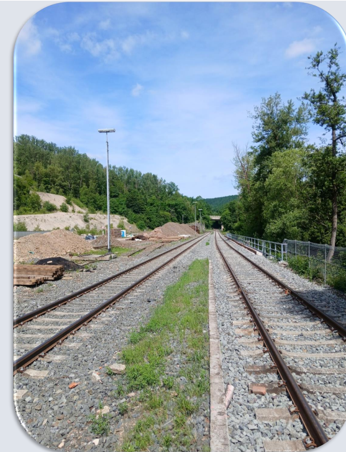
Bahnhof Stromberg Juni 2025 (Gleise vollständig erneuert), Foto Lucas Hirsch
